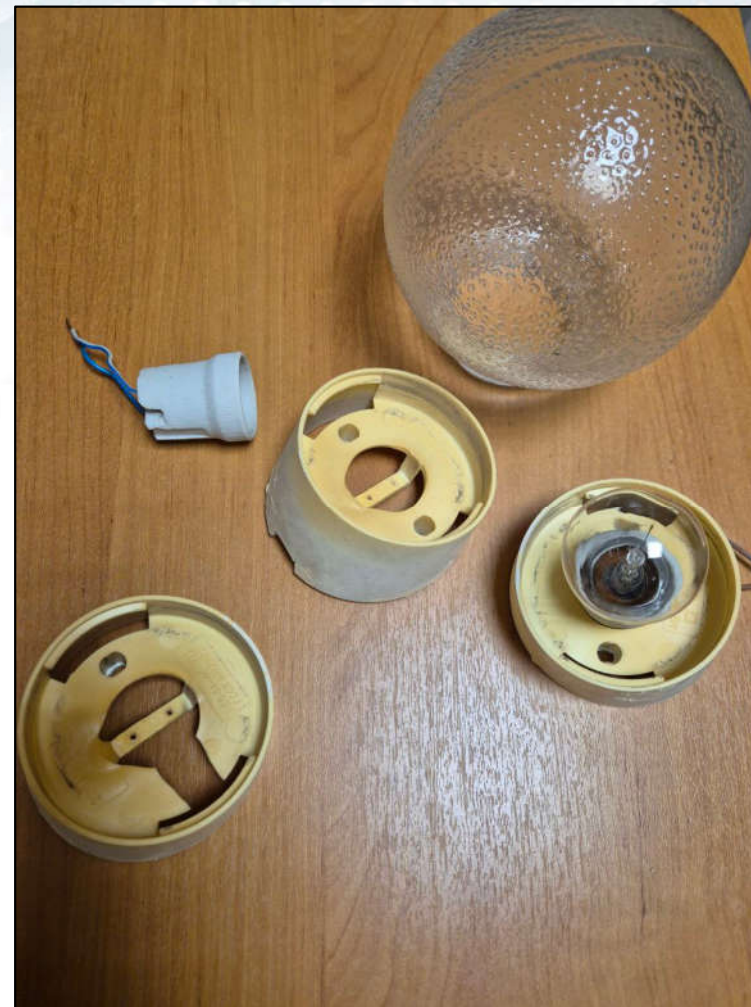
Демонтированные светильники в 1-м подъезде
