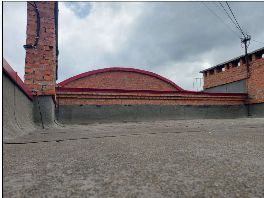
Ремонт кровли 1-го подъезда в 2023 г.
