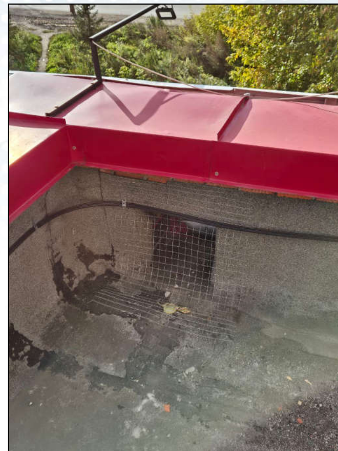
сетки на водометах
