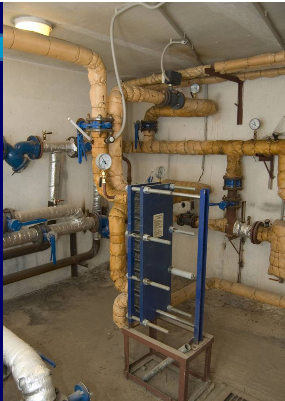
Тепловой узел: пластинчатый водонагреватель («бойлер»)
